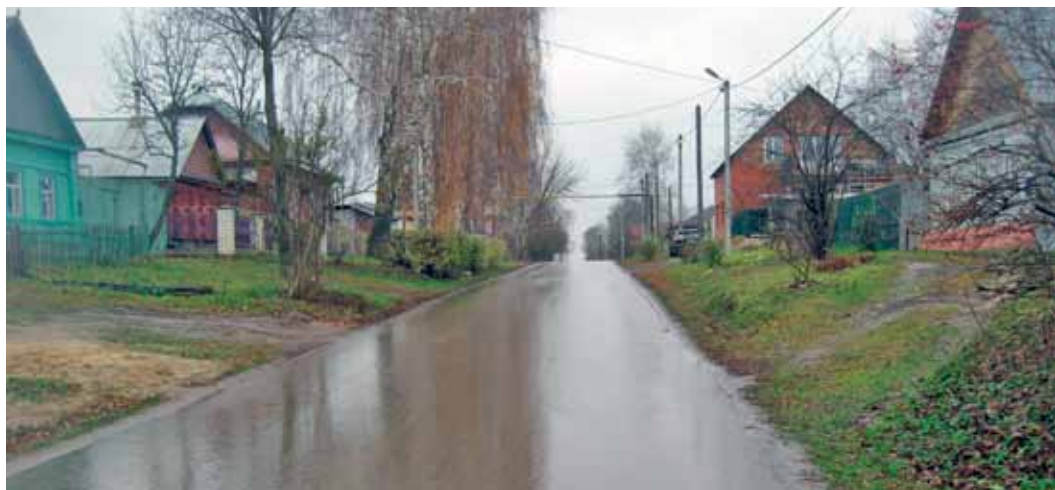
Начало улицы Чехова в г. Белёве идёт по дну засыпанного оврага
